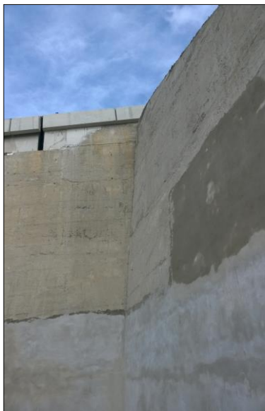
Povrch v průběhu nanášení adhezního mýstku DENSOCRETE 111 a malty MONOMIX WSC TH f
