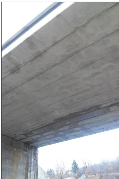
Očištěný pohled mostovky
