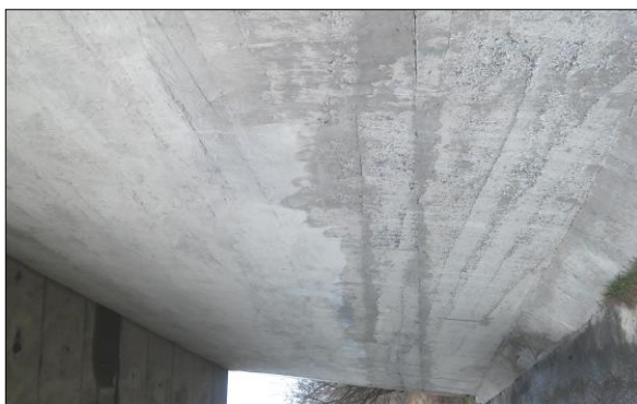
Očištěný pohled mostovky
