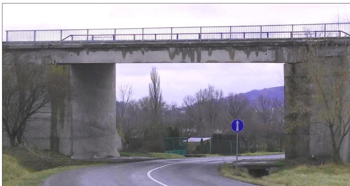
Celkový pohled na most před rekonstrukcí
