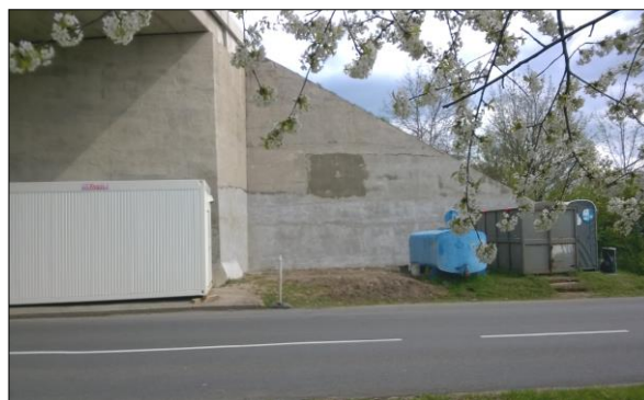
Povrch v průběhu sanace betonu
