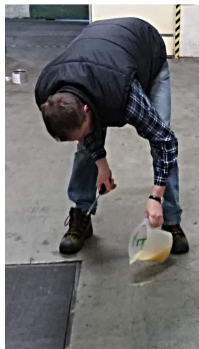
Vlastní realizace zalévání trhlin
