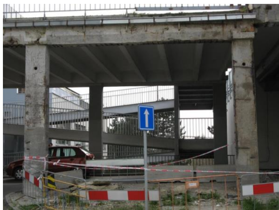
Stav konstrukcí sloupů a průvlaků před provedením sanačního zásahu
