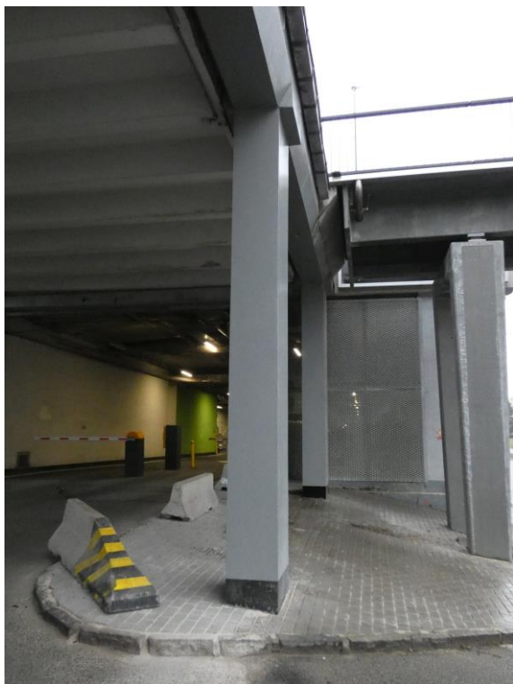
Opravené konstrukce sloupů včetně nátěru nad úrovní základů v patě sloupů
